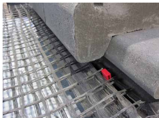
Bilde 3. Montering av Geonett.
