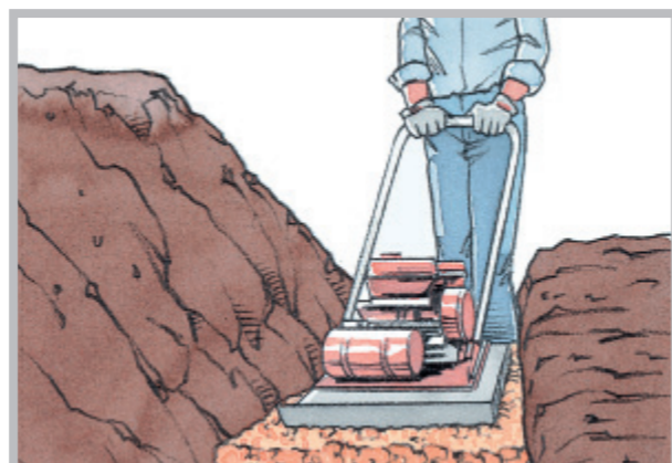
2 KOMPRIMERING AV AVRETTINGSLAGET (sålen)*
